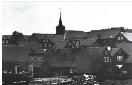
Abbildung 27: Blick auf das Schieferdorf (Quelle: Chronik "800 Jahre Gemeinde Reichenbach", Gemeinde Reichenbach)
